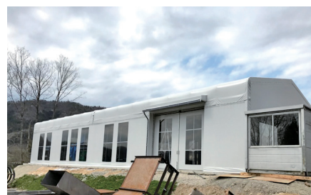
完成した大型テント
