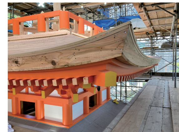
規矩術が駆使された五重塔屋根の軒反り②
