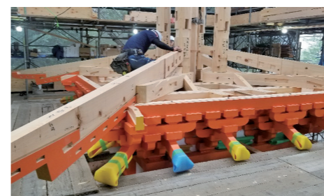
五重塔組み上げの様子
